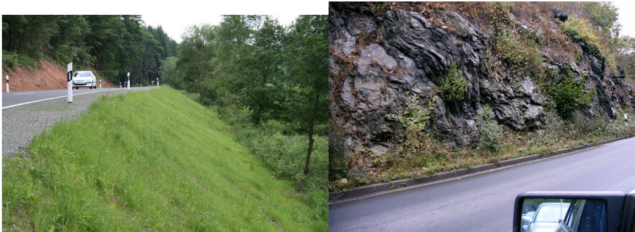
Πρανή επιχωμάτων H > 3m και ορυγμάτων με κλίση υ:β > 1:3 – Κατηγορία κινδύνου 4
