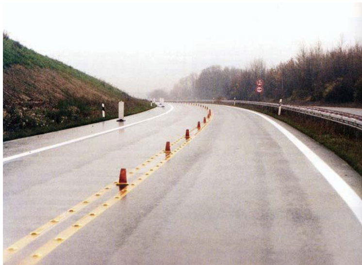
Σχήμα 4.3-2: Παράδειγμα εφαρμογής ανακλαστήρων οδοστρώματος και εύκαμπτων οριοδεικτών μικρού ύψους
