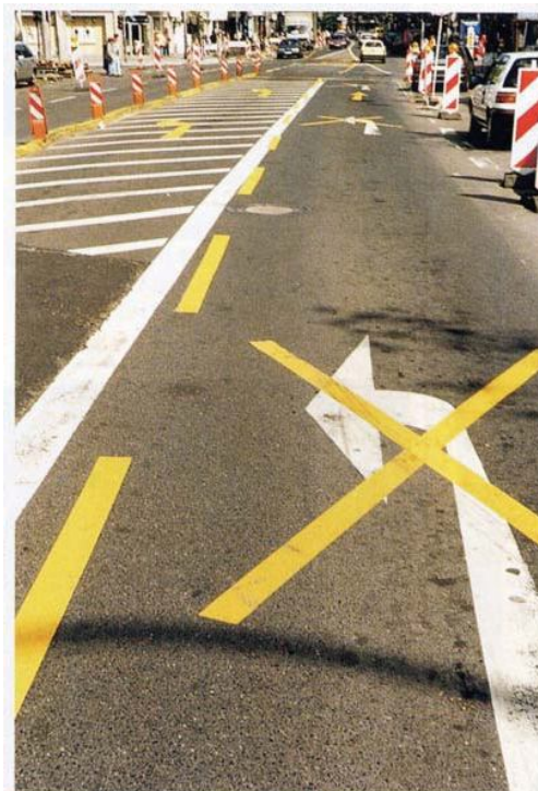
Σχήμα 4.2-1: Παράδειγμα προσωρινής κατάργησης της ισχύος μόνιμης σήμανσης
