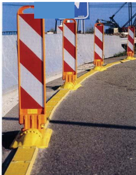
Σχήμα 5.2.2-3: Παράδειγμα οριοθέτησης διαδρόμου κυκλοφορίας (πινακίδες, οριογραμμή και ανακλαστήρες στις βάσεις στήριξης των πινακίδων)
