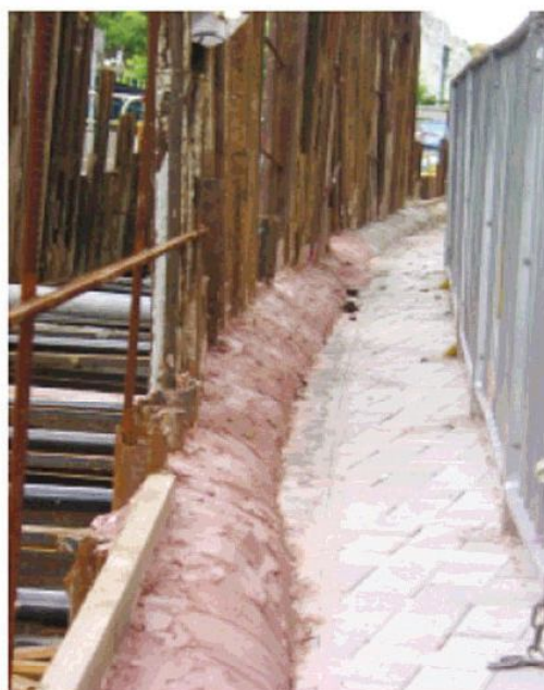
Σχήμα Β-4: Προστασία σκάμματος από επιφανειακή απορροή
