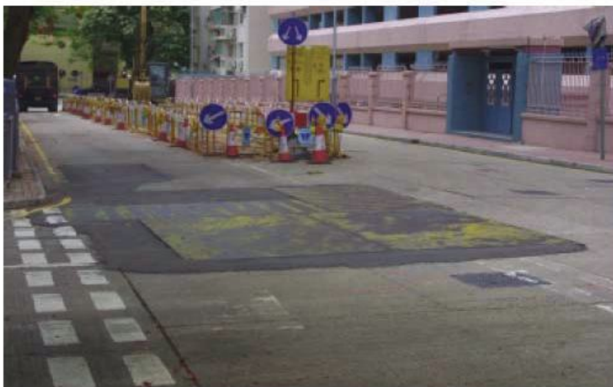
Σχήμα Β-5: Κάλυψη σκάμματος με χαλυβδόφυλλο
