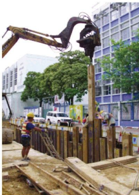
Σχήμα Β-3: Εγκατάσταση αντιστήριξης με έμπειξη δοκών
