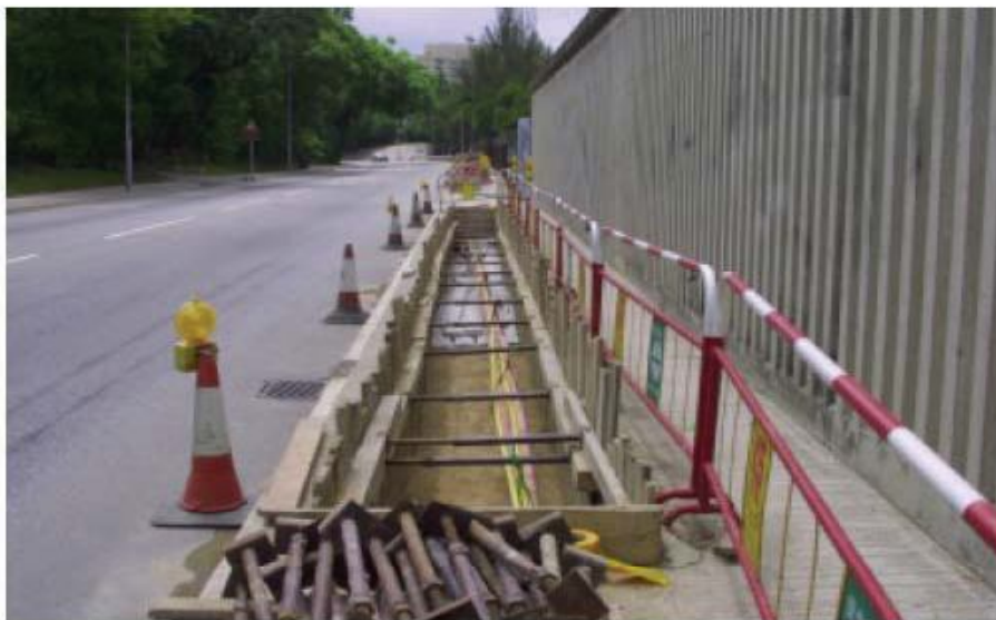
Σχήμα Β-1: Αντιστήριξη με ξυλοσανίδες για μικρό βάθος σκαμμάτων
