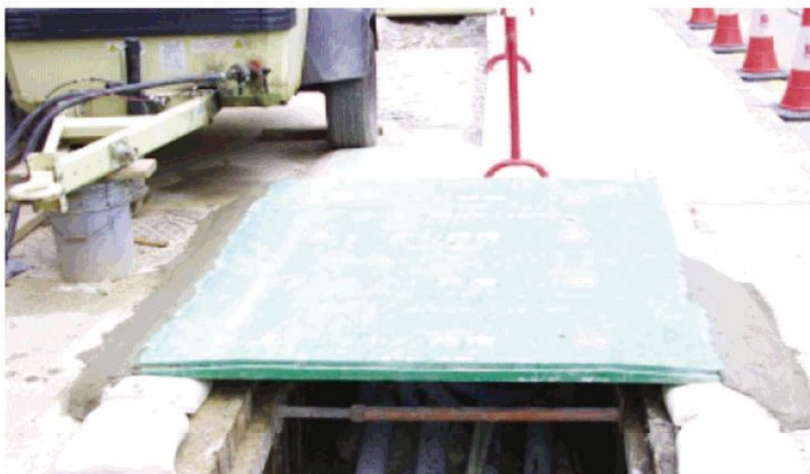
Σχήμα Β-6: Γεφύρωση σκάμματος με σανίδα fiberglass για διέλευση πεζών (πριν από την προσθήκη πλευρικού κιγκλιδώματος)
