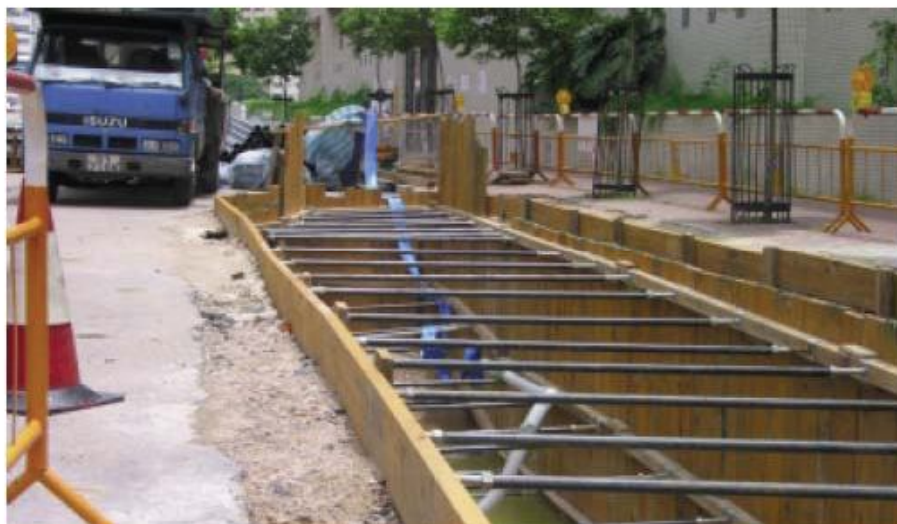
Σχήμα Β-2: Αντιστήριξη με ξυλοσανίδες για μεγάλο βάθος σκαμμάτων
